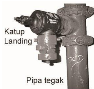
Gambar 4.3.3.(2) - Pipa tegak dan katup landing
